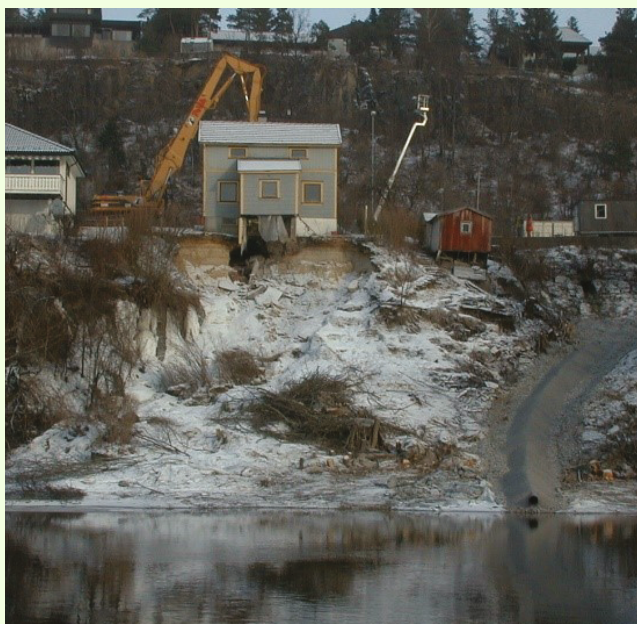
Utrasing av elvekant etter kraftig nedbørsperiode
