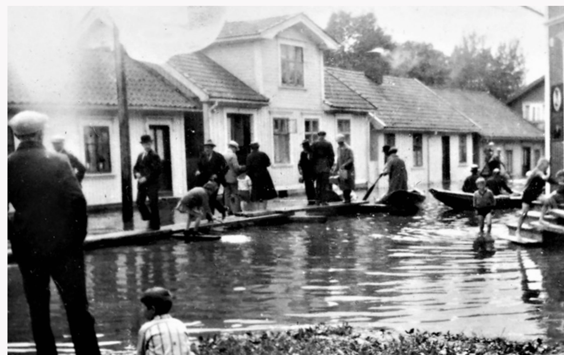
FLOM: Bydelen Bakken har alltid vært utsatt for flom. Vårflommene kom med snøsmeltinga, og høstflommene kom med mye nedbør. Bildet er trolig fra rekordflommen i 1927 og viser vannstanden nederst i Blekebakkevegen. Foto: Ukjent.
