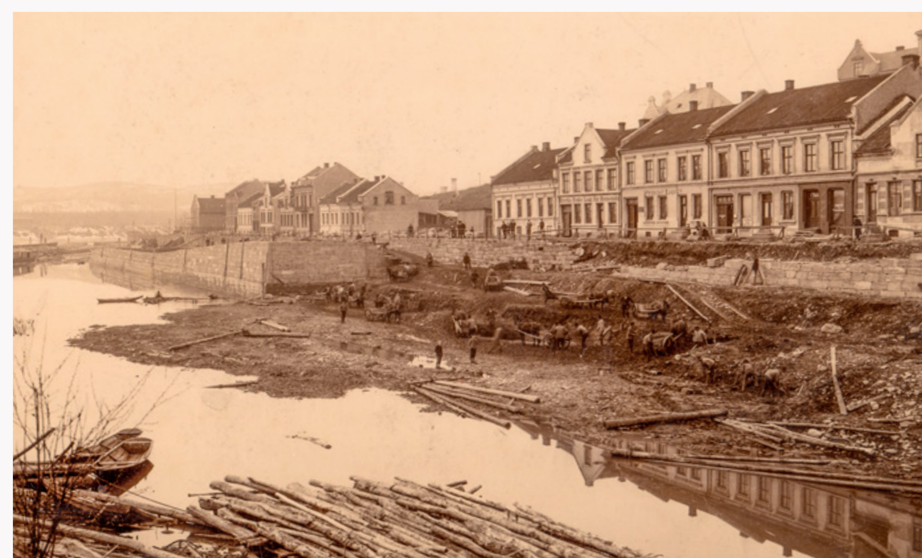
BYGGING: Hjellebrygga sto ferdig i 1911 etter ei byggetid på mer enn ti år. I alt kosta brygga 133 000 kroner. Den høyeste delen av Hjellebrygga blei brukt når det var flom. Foto: R. Nyblin.
