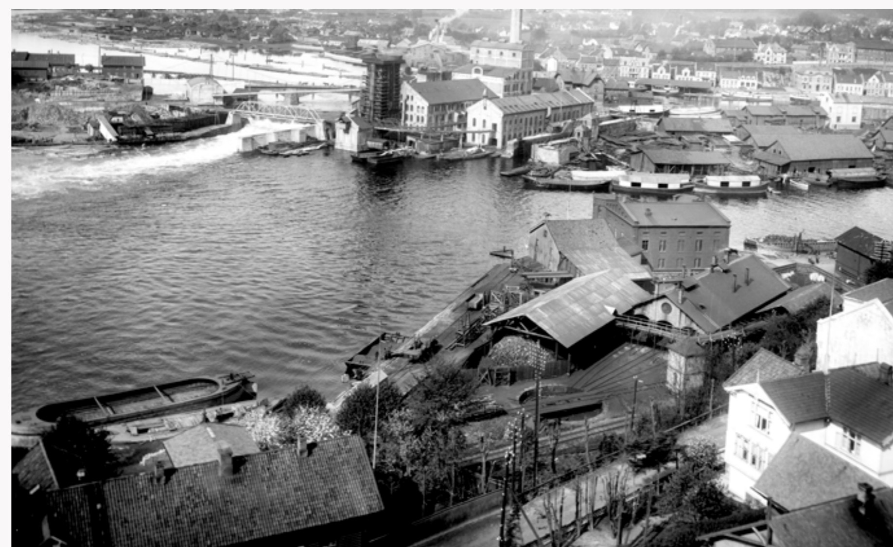
TOLLBODEN: Bildet er tatt mellom 1910 og 1920. Dreieskiva ved Tollboden blei brukt til å snu lokomotiva. Det var nødvendig siden Skien G var endestasjon på denne jernbanestrekningen. På Smieøya ligger Unions fabrikk. I det lange bygget langs slusa lå Papirmaskin nr. 5. Huset kalles PM5 og er nå freda. Foto: Narve Skarpmoen
