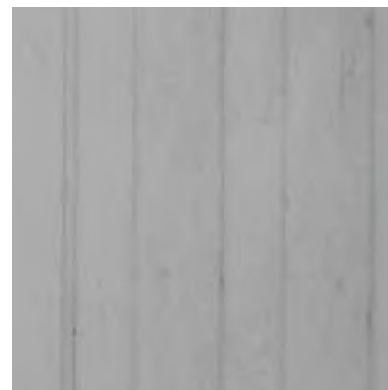
Vekselpanel/notpanel. Skarp kant eller profilert. Man gjorde forsøk på å etterligne murte hus.
