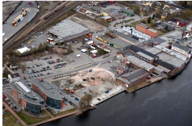
Union i Drammen i 2003 etter riving og oppbygging. Copiright Mapaid AS
