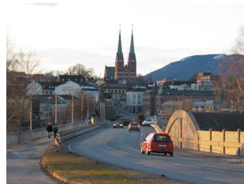
Riksveien er en viktig gjennomgående transportåre. Foto: Asplan Viak AS.
