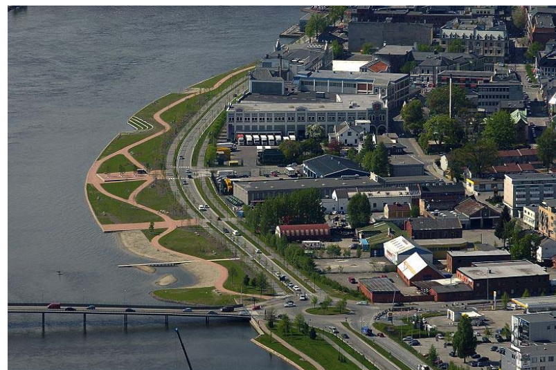
Union i Drammen - Bragernes strand. Foto: Drammen kommune.
