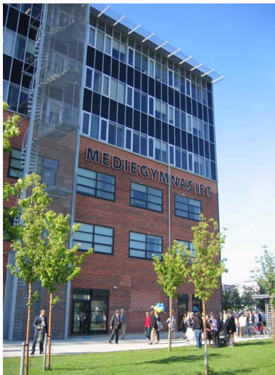
Mediegymsiet i Malmø er et eldre industribygg, en ubåthall, som er ombygget.
