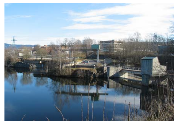
Vestsiden av Klosterøya inn mot kraftverket. Foto: Asplan Viak AS.
