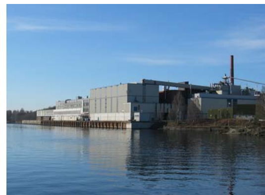
Klosterøya har flere bygninger med store volumer. PM 6 og 7 som ligger på østsiden av øya har det største volumet. Foto: Asplan Viak AS.
