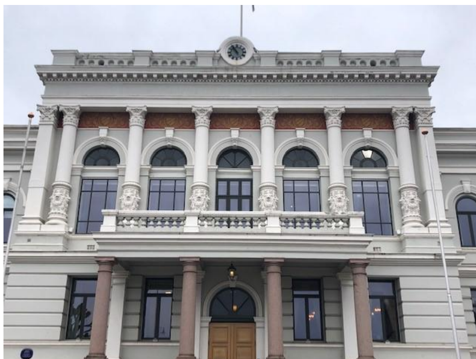
Nye vinduer på rådhuset
